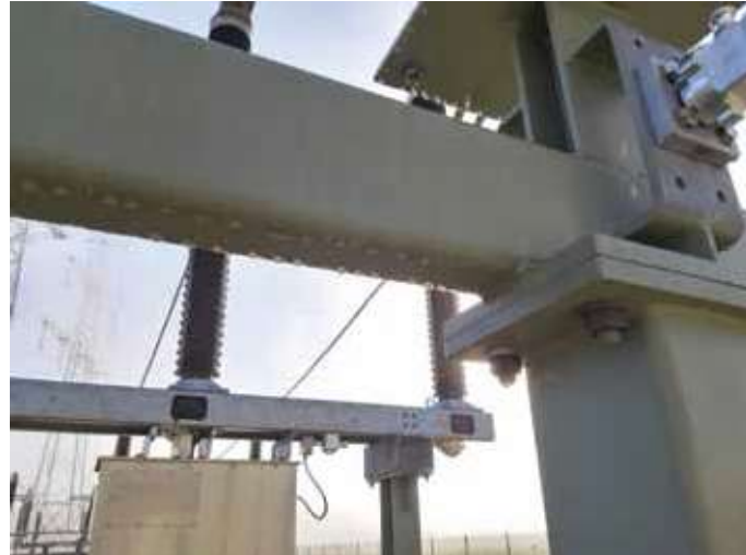
Nebel und Tau- eigentlich schlechte Bedingungen für Beschichtungsarbeiten © Geholit + Wiemer Lack- und Kunststoff-Chemie GmbH
