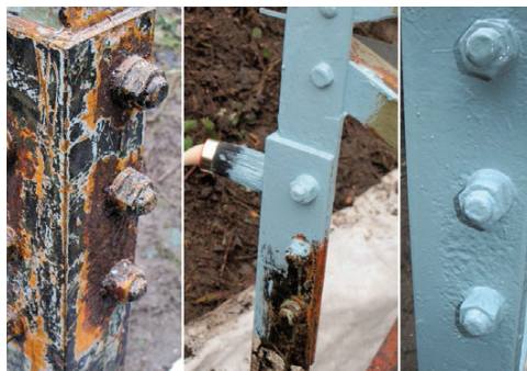
Die einkomponentigen High-Solid-Produkte können je nach Bauteilgeometrie mit verschiedenen Applikationsverfahren auf die unterschiedlichen Untergründen aufgebracht werden. Foto: Geholit+Wiemer
