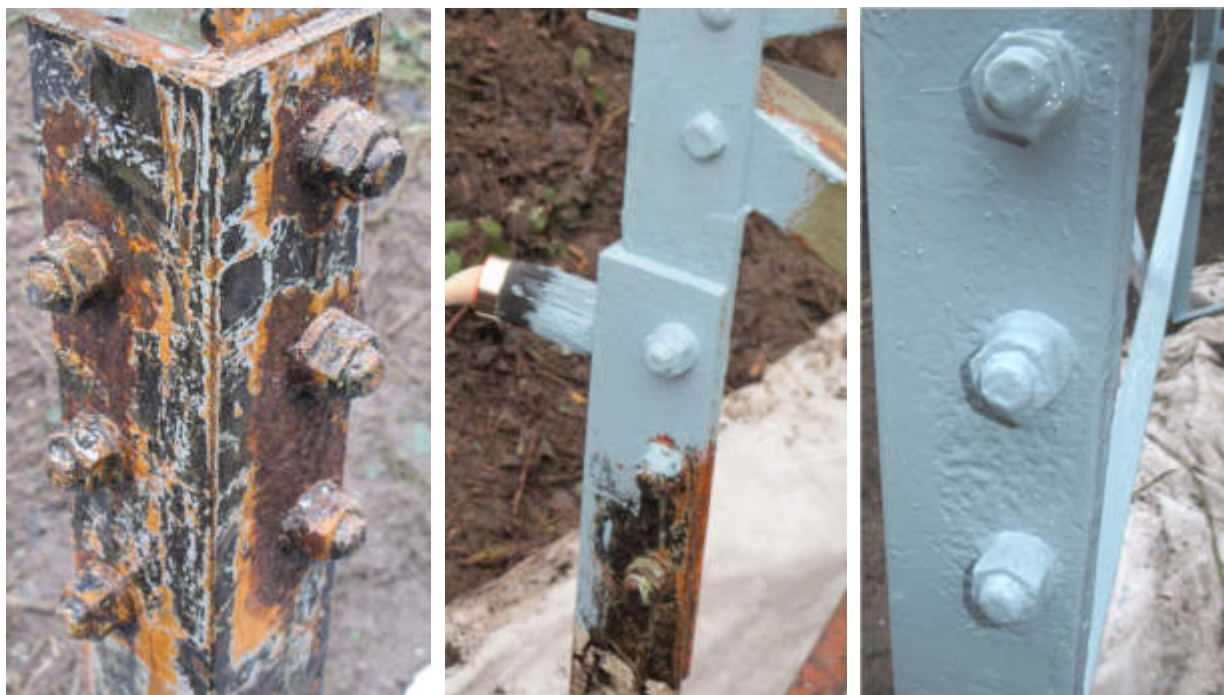
Malowanie masztu linii napowietrznych powłoką WIEMERDUR-Z10AW-Metallgrund w bardzo trudnych warunkach atmosferycznych w dniu 05.02.2019
