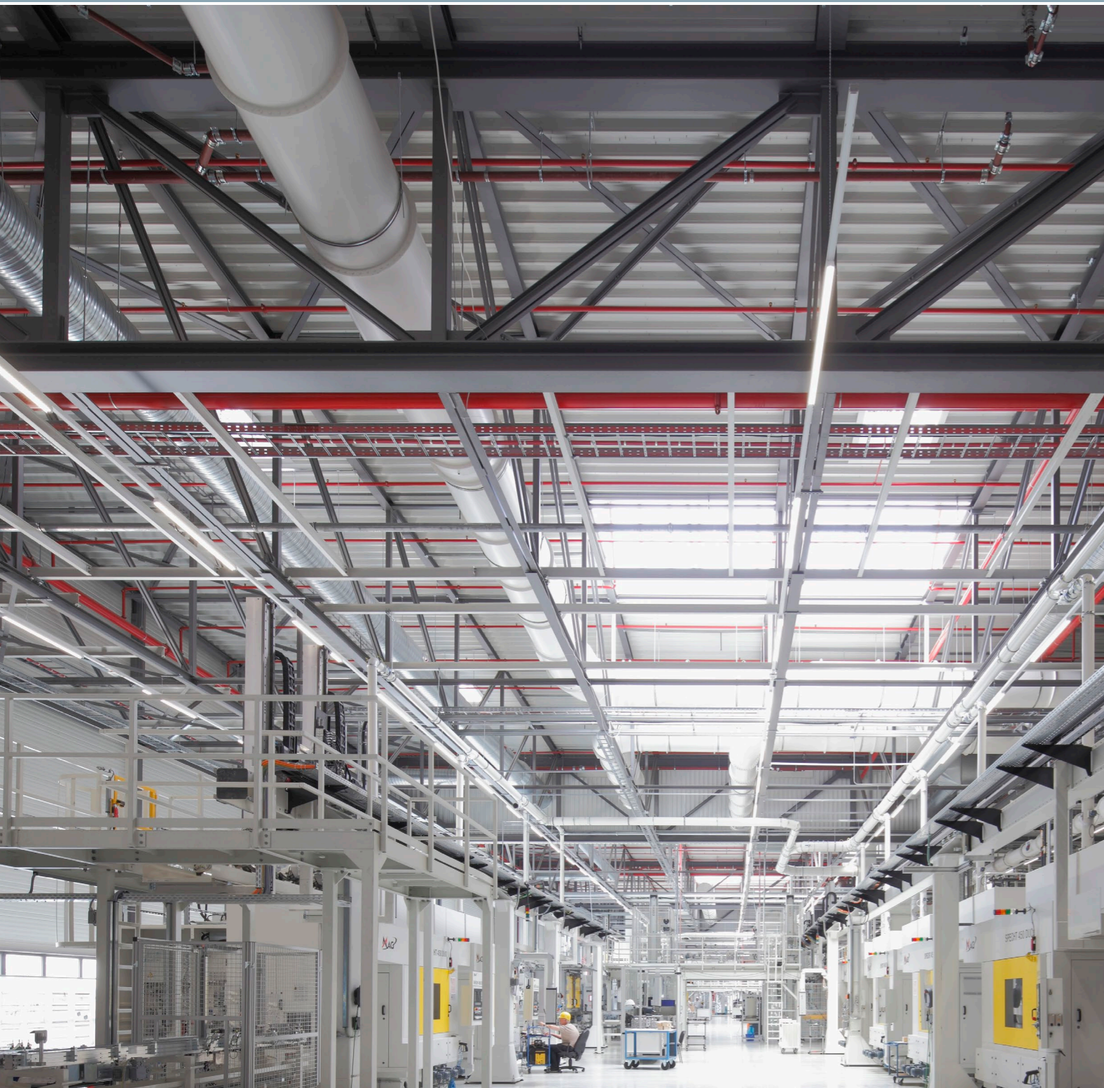
Produktionshalle VW-Motorenwerk, Chemnitz
