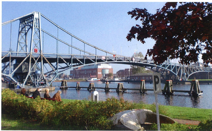
Bild 1: Die Kaiser-Wilhelm-Brücke ist das weit über Stadtgrenzen hinaus bekannte Wahrzeichen der Küstenstadt Wilhelmshaven. Die KW-Brücke – wie sie im Volksmund genannt wird – führt über den Großen Hafen und verbindet die Südstadt mit der Maritimen Meile mit den zahlreichen Museen und Erlebniswelten. Die KW-Brücke wurde von 1905 bis 1907 für 1,625 Millionen Goldmark als die damals größte Drehbrücke Europas mit einer Spannweite von 159 m und einer lichten Höhe von 9 m erbaut und am 4. September 1907 in Betrieb genommen. 1975 wurde die Brücke unter Denkmalschutz gestellt
