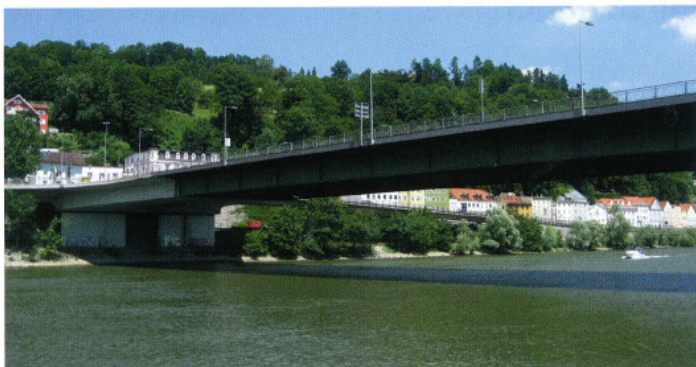
Bild 1: Die Schanzlbrücke bei Passau (High-Solid-Korrosionsschutz mit Blatt 94-Zulassung)
