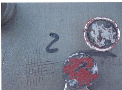
Bild 5. ENBW-Mast bei Karlsruhe, Prüfstelle 2
