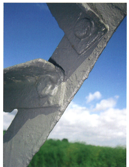
Bild 13. ENBW-Trasse Rheinau-Altlußheim, Anschlussbereich Diagonale-Eckstiel
