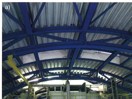
Bild 10. Südtribüne des Badenova-Stadions des SC Freiburg, Zustand der beschichteten Stahlkonstruktion
