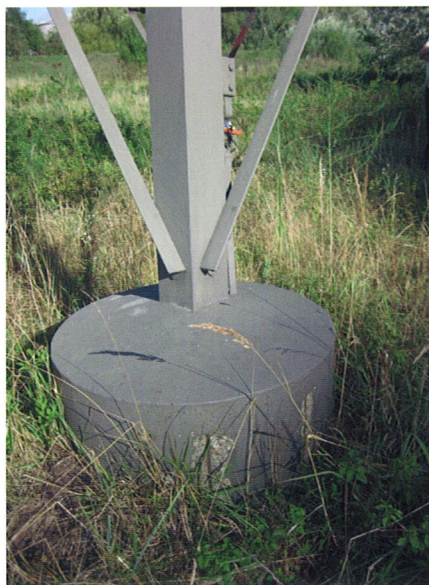
Bild 6. ENBW-Mast bei Karlsruhe, Fußbereich
