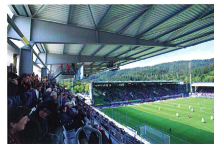
Bild 9. Südtribüne im Badenova-Stadion des SC Freiburg
