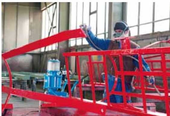
Korrosionsschutz-Beschichtung bei Peer Stahlbau
