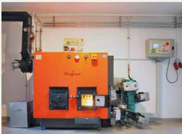
Heizanlage für Biomassen (links) und Holzhackmaschine (rechts). Die Lackierung muss neben einer hochwertigen Optik eine sehr gute Haftung und hohe mechanische Beständigkeit aufweisen.
