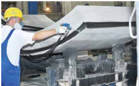
Spritzauftrag eines Spezialklebers auf Betonsegmente
