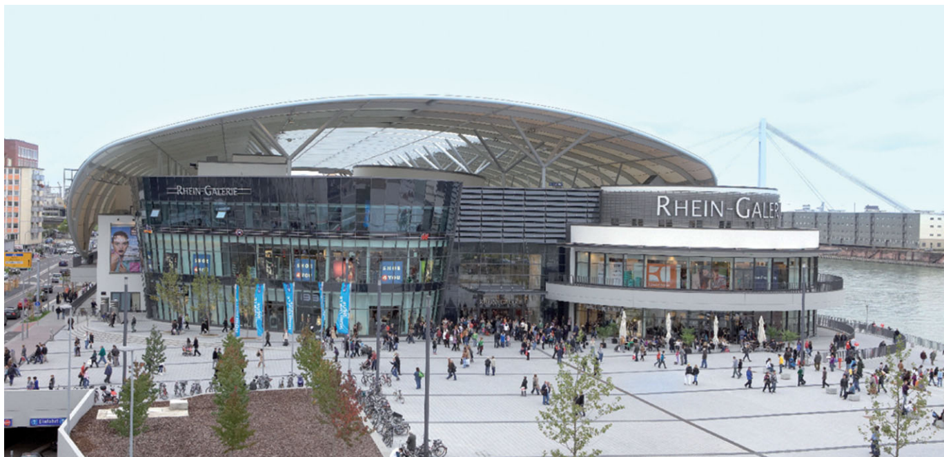
Bild 1. ECE Rhein Center Galerie Ludwigshafen: Korrosionsschutz mit WIEREGEN-M16R (160 µm im Werk) und WIEREGEN-M87 in RAL 9002 (60 – 80 µm am Objekt)
