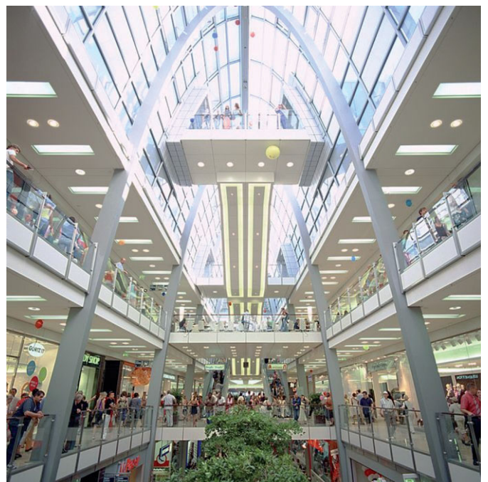
Bild 3. ECE Center Karlsruhe: dreischichtiger Korrosionsschutzaufbau bei den tragenden Säulen mit der Deckbeschichtung WIEREGEN-M87 im Eisenglimmerfarbton DB 704, die wegen den besonderen optischen Ansprüchen nach dem Aufbau der Stahlkonstruktion vollflächig aufgerollt wurde.
