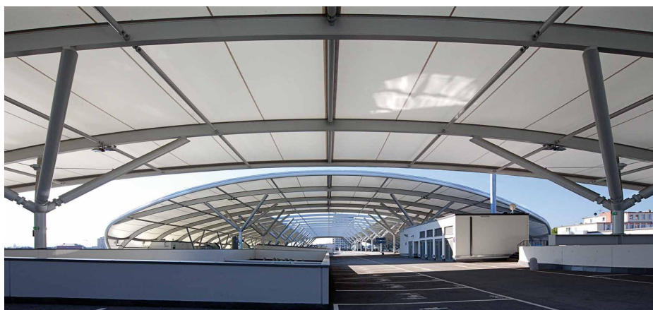
Abb. 2: Beschichtung der Stahlkonstruktion des Preview-Geländes der Technischen Universität München mit einem Hydro-Hybrid-System bestehend aus der Hydro-Grundbeschichtung (Applikation im Werk) und der lösemittelhaltigen PUR-Deckbeschichtung mit Eisenglimmereffekt (nach der Montage).
