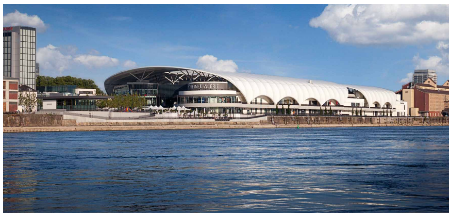
Abb. 1: Rhein-Galerie Ludwigshafen, DGNB-Zertifikat in Gold in 2011 für die nachhaltige Planung und städtebauliche Integration. Durch den Einsatz von zahlreichen elliptischen Glasdächern, die entlang der zentralen Galerie-Achse angeordnet sind, steht ein Maximum an Tageslicht zur Verfügung, was zur Verringerung des Stromverbrauchs und damit zur Reduzierung der CO 2 -Belastung der Umwelt führt (Foto: ECE).
