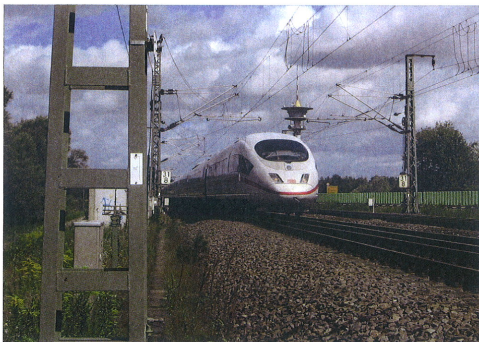
Bild 4. ICE-Strecke der DB AG, Mannheim; einschichtiger Hydrokorrosionsschutz auf verzinkten Masten
