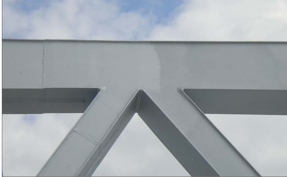
Deckbeschichtung in Weißaluminium RAL 9006: Partielle Überarbeitung nach einigen Monaten Freibewitterung. (Fotos: Geholit + Wiener)
